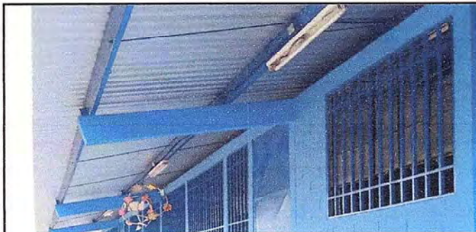
Foto 3: Colocación de balcones
