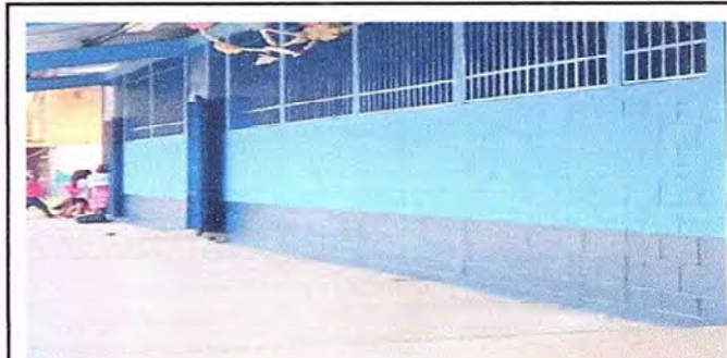
Foto 4: Restauración de pintura en muro exterior de aulas
