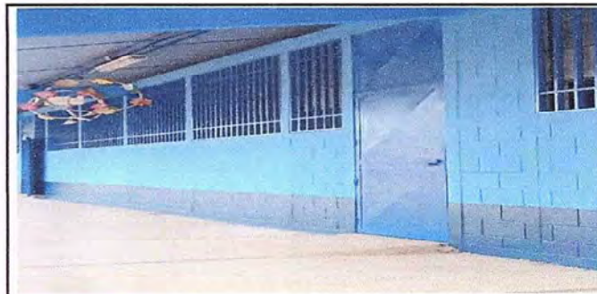
Foto 6: Restauración de pintura de las puertas
