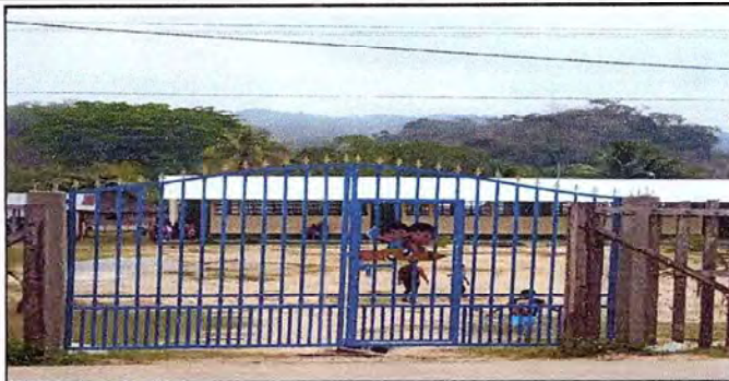
Foto 2: Colocación del portón principal.
